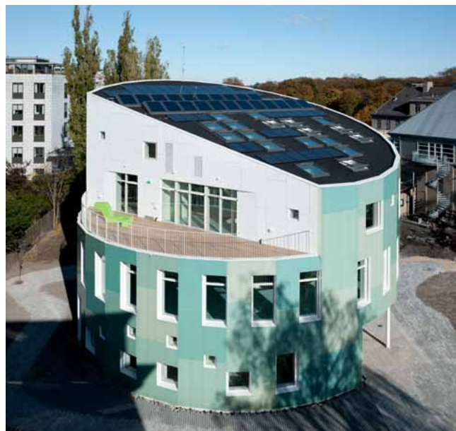
Prvá bez emisná verejná budova v Dánsku Zelený maják (Green Lighthouse), Dánsko
